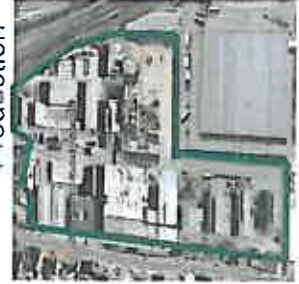
Nuernberg / Bavaria GfE Gesellschaft für Elektrometallurgie mbH GfE Metalle und Materialien GmbH
